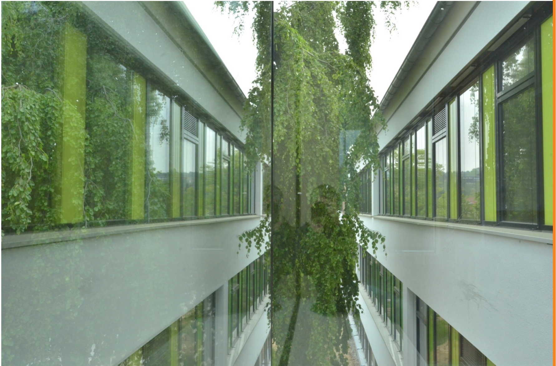
Vorgefertigte Fassaden- Dämmelemente in Modulbauweise, Gebäude 1 (naher)
