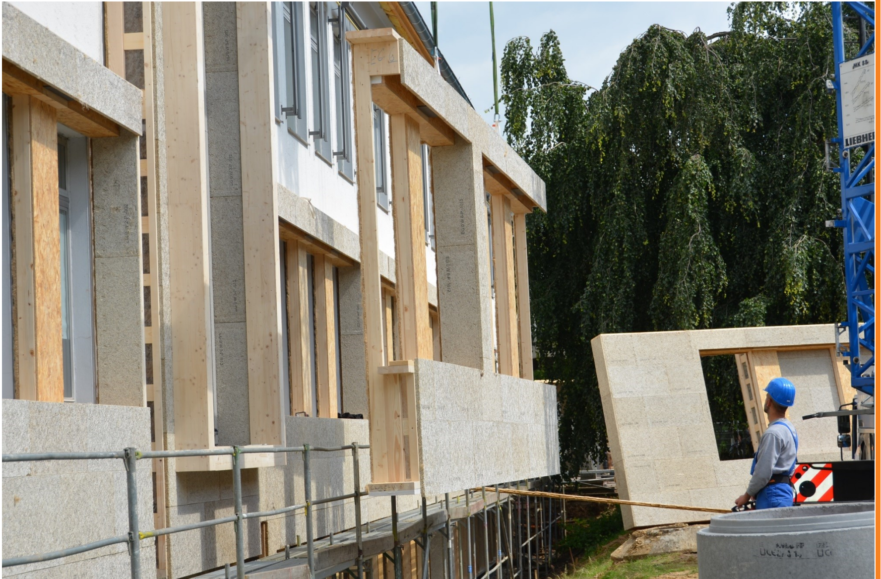
Vorgefertigte Fassaden- Dämmelemente in Modulbauweise, Gebäude 1
