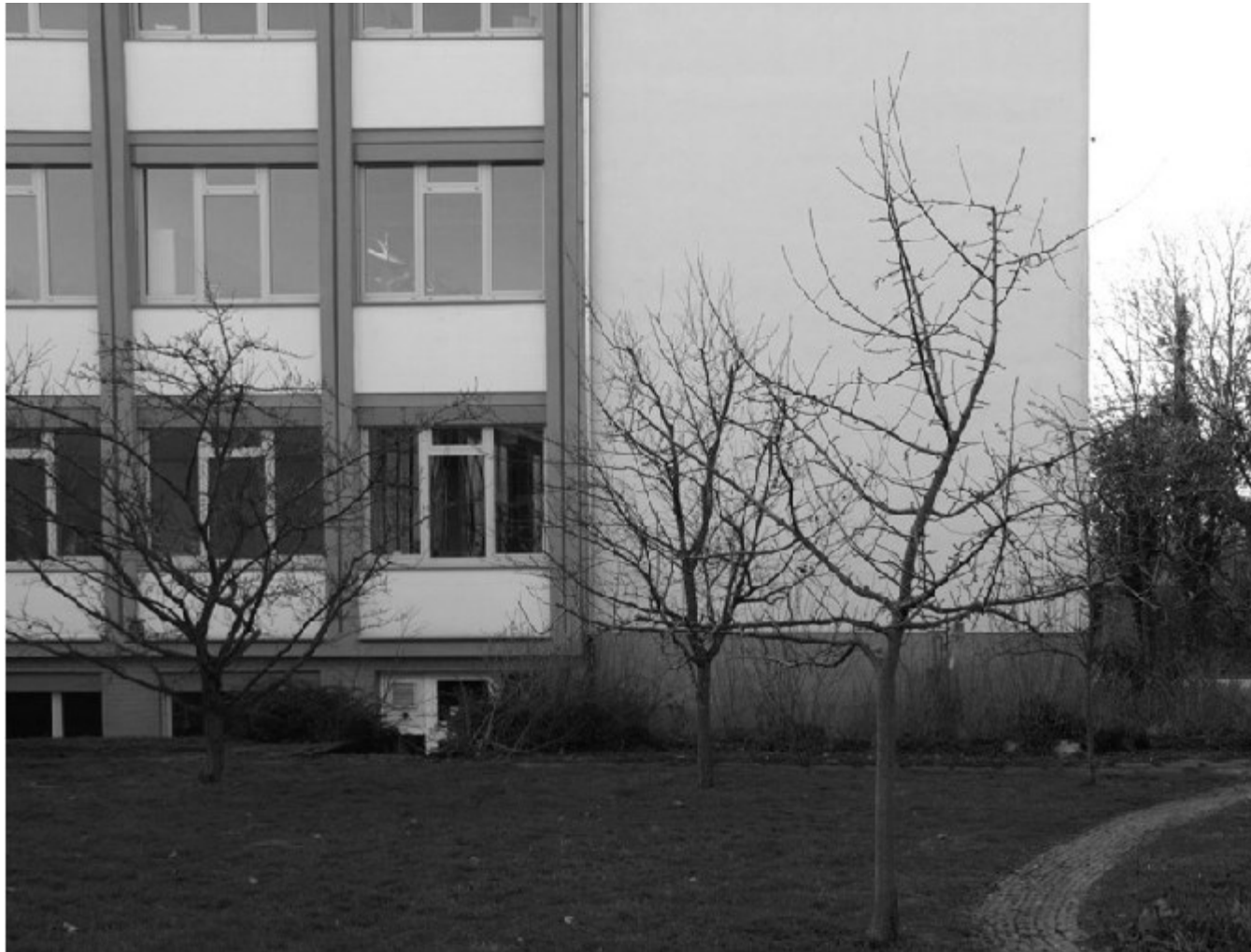
Altbaufassadenteile in unterschiedlichen Ebenen (vorher)
