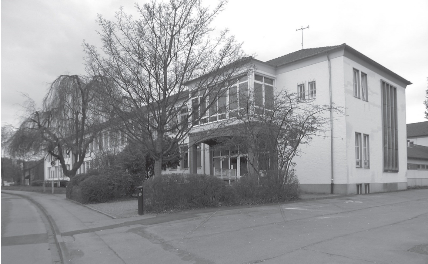
Außenansicht Gebäude 1 (vorher)
